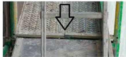
Uszkodzona dolna poprzeczka - rozcięta
