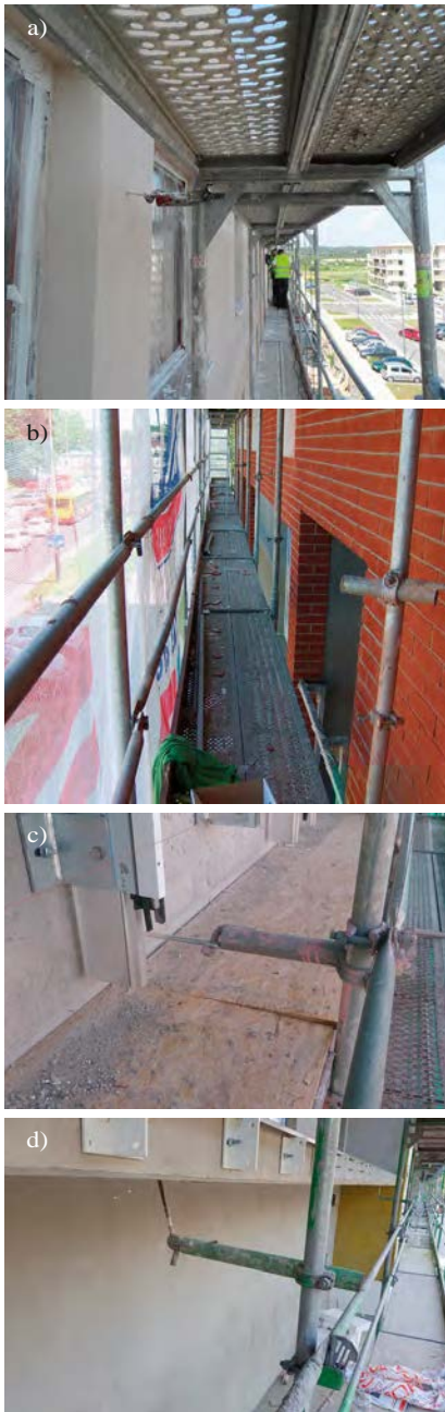
Rys. 1. Przykłady realizacji kotwienia rusztowań
