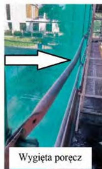
Rys. 3. Przykłady uszkodzeń elementów rusztowań wpływających głównie na bezpieczeństwo pracowników
