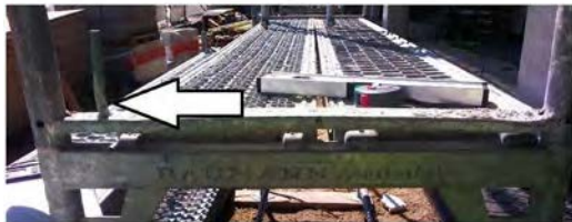
Uszkodzony trzpień mocowania krawężnika - wygięty
