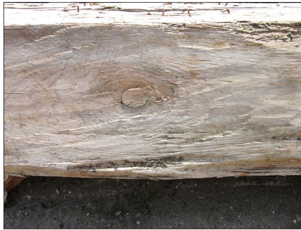
Ryc. 5. Rościszawice, kościół, belka z widocznymi śladami obróbki toporem, rok 2009; fot. U. Schaaf.
