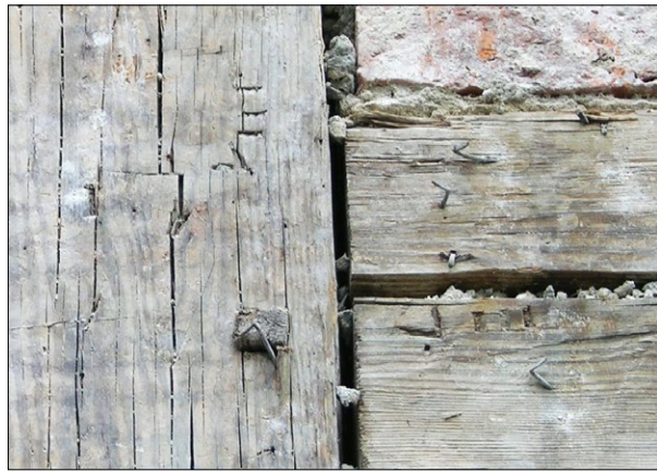
Ryc. 7. Rościszewice, kościół, południowa nawa boczna, ściana południowa, znaki montażowe w postaci rzymskich znaków liczbowych na słupie i ryglu, rok 2009; fot. U. Schaaf.
