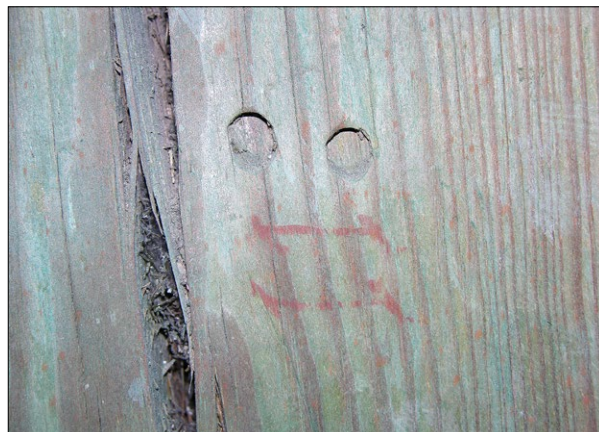
Ryc. 9. Rościszewice, kościół, więźba nad korpusem nawowym, znak montażowy o kształcie okrągłym wykonany dłutem plus znak w postaci kresiek wykonany sangwiną, rok 2009; fot. U. Schaaf.
