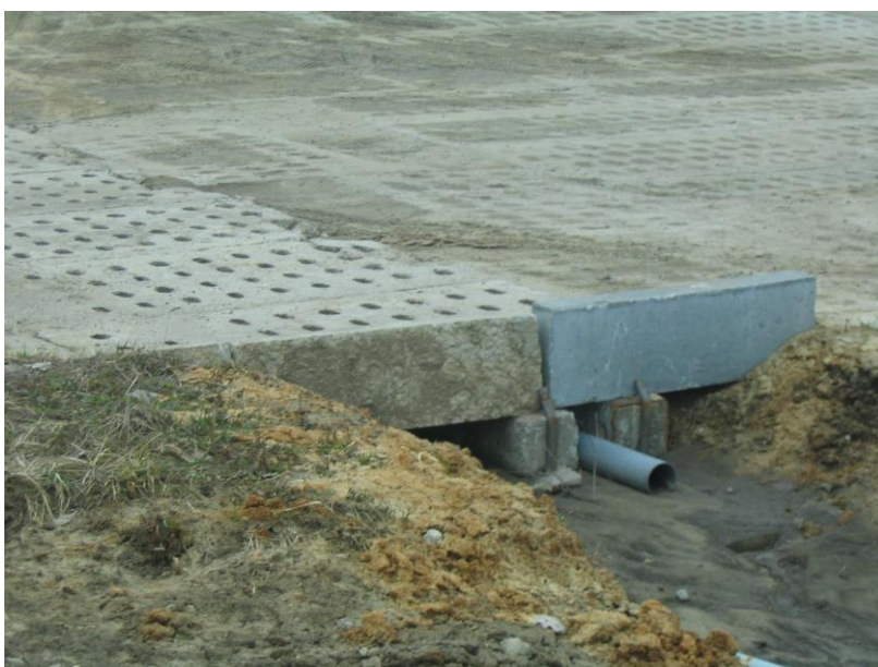
Fot. 3. Sposób wykonania przepustu drogowego Fig. 3 The type of road culvert
