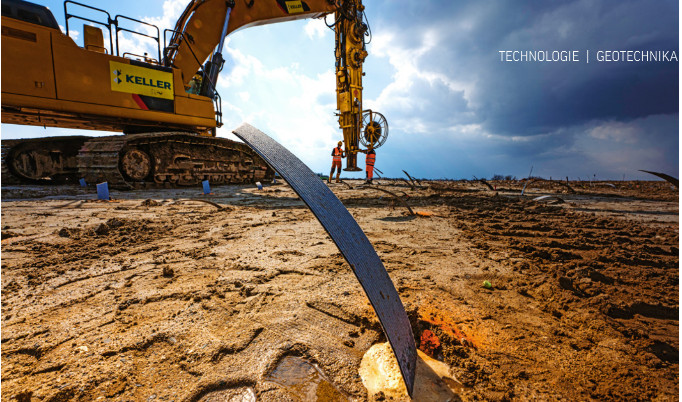
Ryc. 2. Proces instalacji drenów pionowych
