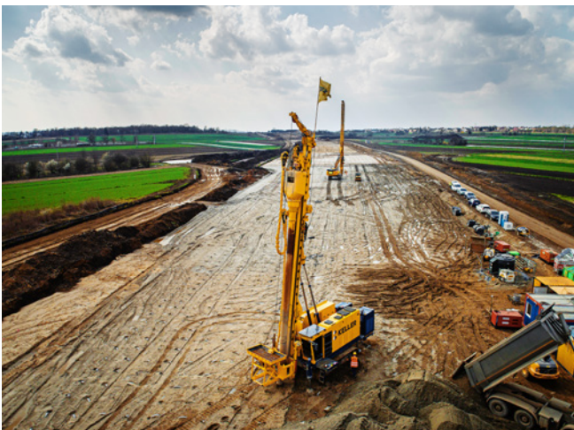
Ryc. 5. Wykonywanie kolumn KSS oraz instalacja drenów prefabrykowanych
