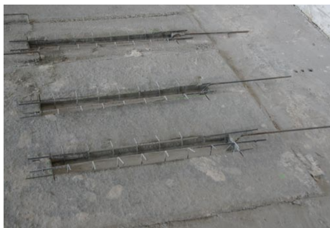
Rys. 5. Zabetonowane kanały do wysokości około 20 mm poniżej górnej powierzchni płyt
