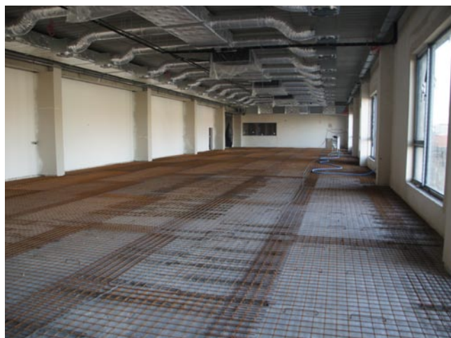
Rys. 6. Strop przygotowany do ułożenia nadbetonu
