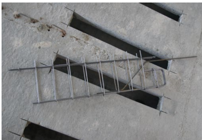
Rys. 3. Zbrojenie wkładane do otwartych kanałów w płycie
