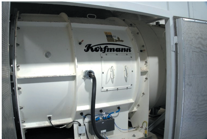
Rys. 4. Wentylator typu dAL16-1100 produkcji firmy Korfmann
