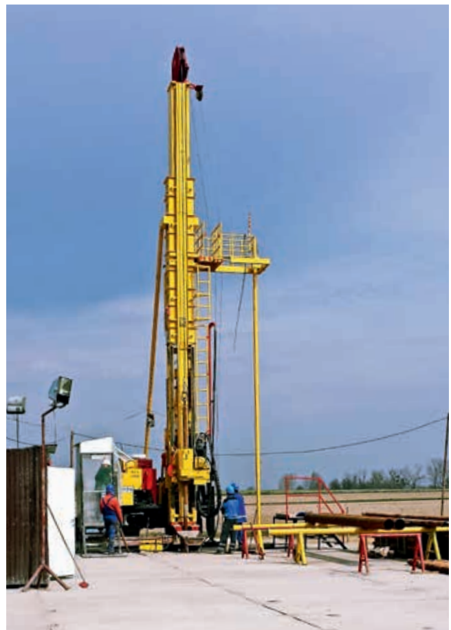
Urządzenie wiertnicze YDX-3000 w trakcie wiercenia otworu Pawłów 5
