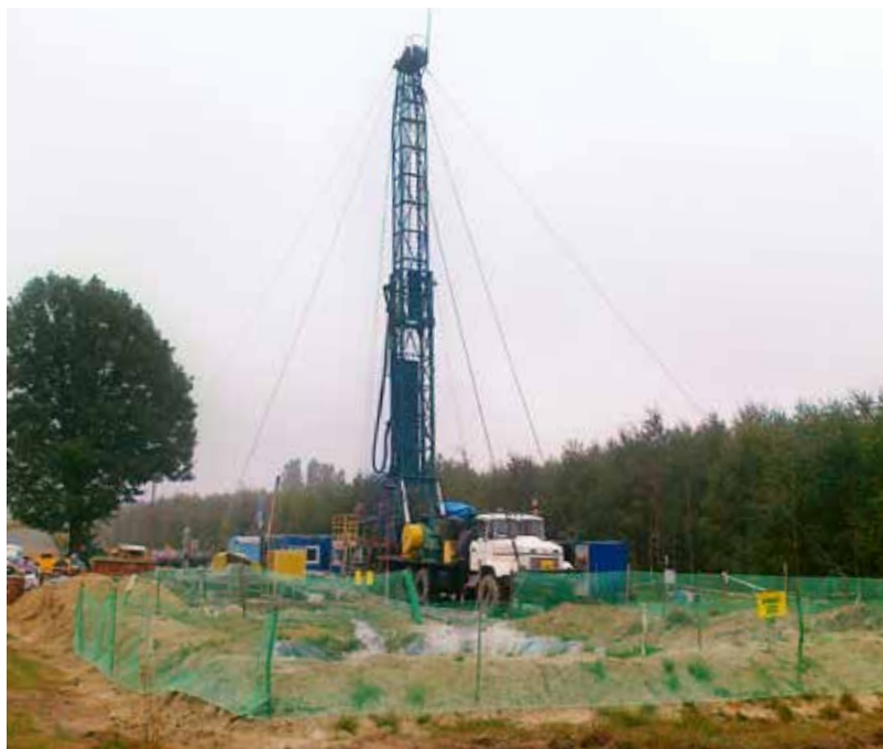
Urządzenie wiertnicze UPA-80PKh w trakcie wiercenia otworu Pawłów 4
