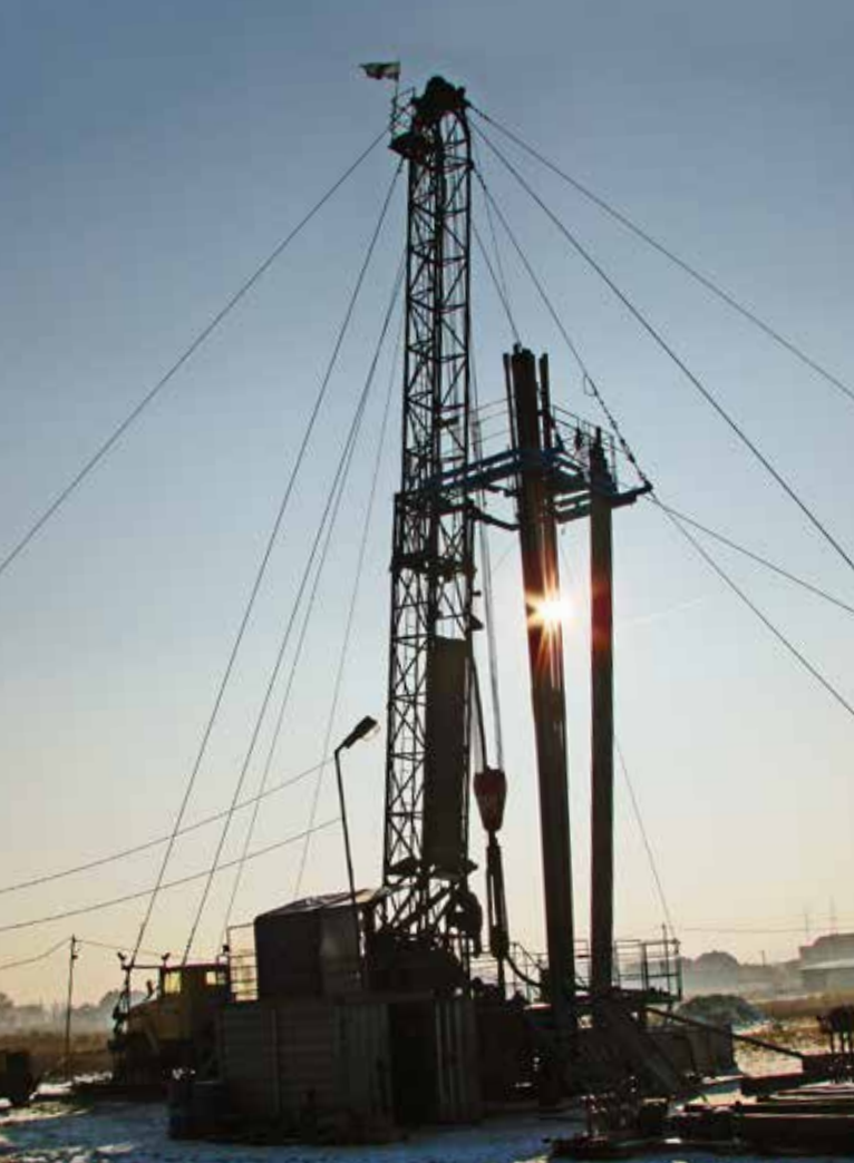
Urządzenie wiertnicze A-60 w trakcie wykonywania otworu badawczego
