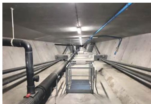
Rys. 14. Przykład otworu dostępowego oraz łagodnych najazdów transportowych
