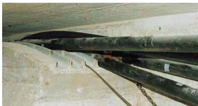
Rys. 9. Przykład dewiatora podporowego (siodła) z dostępem górnym według [2]
