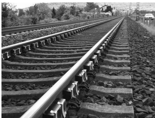
Fot. 5. Zamontowane nakładki na szyny
