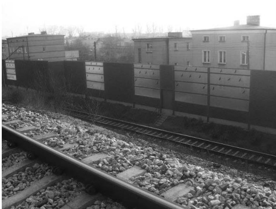
Fot. 13. Ekran akustyczny w Poznaniu
