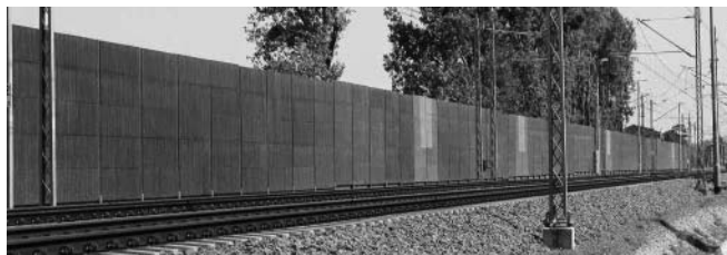
Fot. 12. Ekran akustyczny na linii kolejowej E-30
