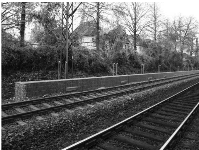
Fot. 9. Niski ekran akustyczny gabionowy
