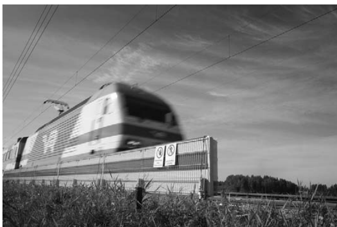
Fot. 10. Niski ekran akustyczny z tworzywa Źródło: www.soundim.fi
