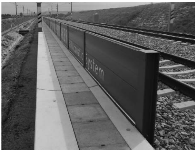
Fot. 11. Niski ekran akustyczny żelbetowo-aluminiowy z ciągiem komunikacyjnym Źródło: fotograf Kamil Hajduk
