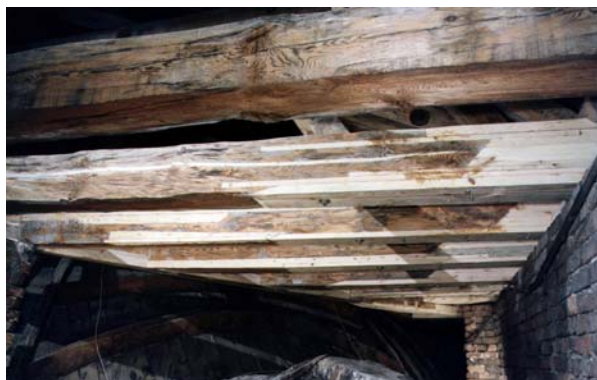
Ryc. 22. Zrekonstruowane podwaliny i belki stropowe. Widok z dołu Fig. 22. Reconstructed ground beams and floor beams tips – bottom view
