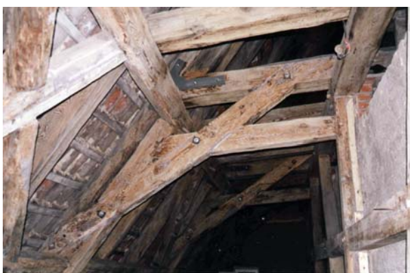
Ryc. 29. Wzmocniony zastrzał po zakończeniu montażu Fig. 29. Reinforced brace after assembly
