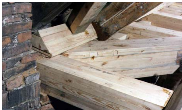
Ryc. 18. Zrekonstruowana strefa podporowa wiaźara pełnego z ryc. 17 Fig. 18. Reconstructed support section of the main truss from fig. 17
