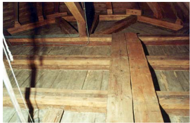
Ryc. 9. Fragment zrekonstruowanego stropu poddasza (kościół pw. św. Józefa w Kicinie)
