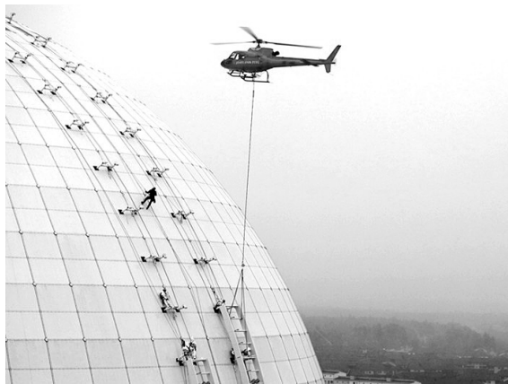
Fot. 2. Montaż konstrukcji jezdnych (Materiały promocyjne firmy Liftbyggarna)
