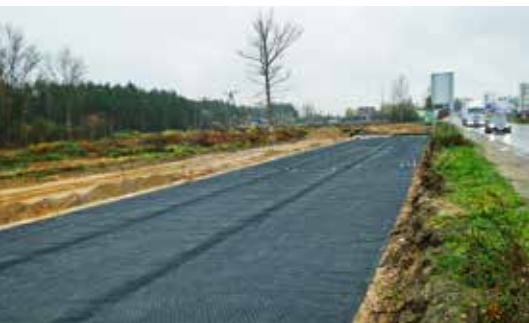
Jezdnia wschodnia ul. Ks. Ściegiennego w Kielcach – etap realizacji, listopad 2014 r.
