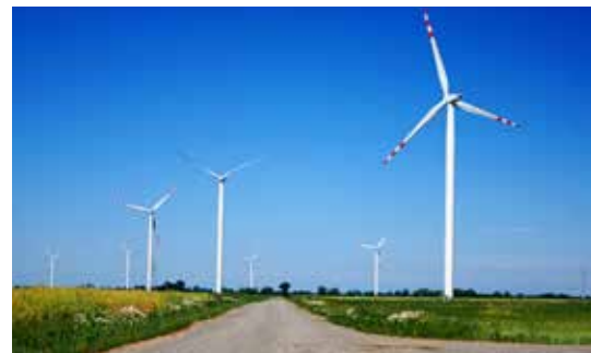
Farma wiatrowa Nowy Staw po zakończeniu prac, czerwiec 2013 r.
