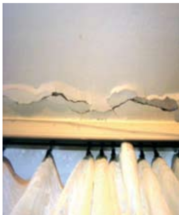
Rys. 6. Zarysowania stropu w obszarze wieńca mocującego płytę balkonową przechodzące na ścianę działową [źródło: opracowanie własne]
