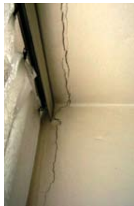
Rys. 6. Zarysowania stropu w obszarze wieńca mocującego płytę balkonową przechodzące na ścianę działową [źródło: opracowanie własne]
