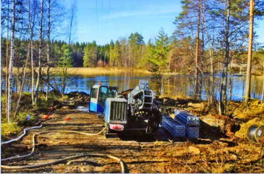
Ryc. 5. Wiertnica w czasie prac przewiertowych [4]
