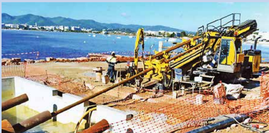
Ryc. 4. Wiertnica w czasie prac przewiertowych [4]
