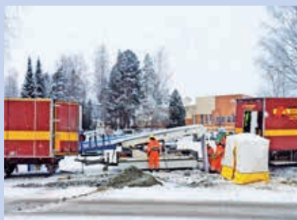
Ryc. 2. Bezpośrednie wprowadzanie linera z przyczepy za pomocą przenośnika taśmowego [1]
