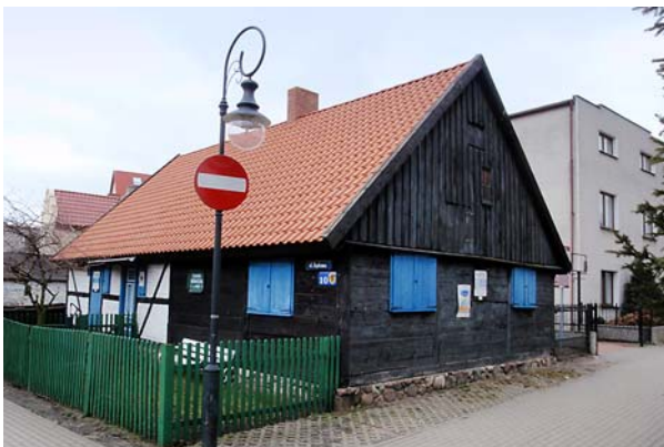
Ryc. 1. Dom rybaka w Jastarni (fot. P.M. Pogodziński) Fig. 1. Fisherman's house in Jastarnia (photo P.M. Pogodziński)
