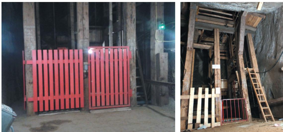
Rys. 6. Wrota szybowe na nadszymbiu (z prawej wygląd historyczny)
