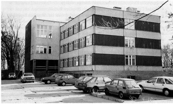
Rys. 4. Budynek przy ul. 26 Kwietnia 10 w latach 80.
