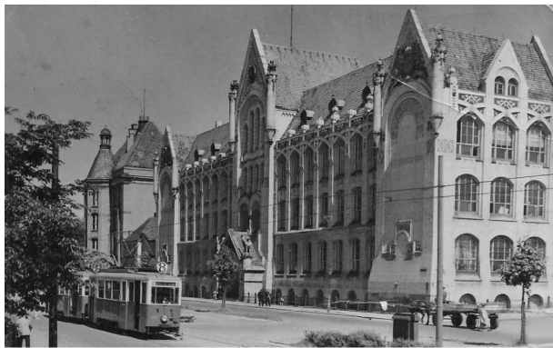
Rys. 2. Zdjęcie gmachu przy ul. Sikorskiego 37 z 1957 r.
