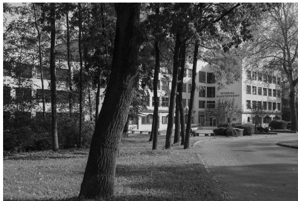
Rys. 5. Budynek przy ul. 26 Kwietnia 10 obecnie
