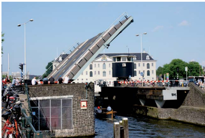
Fot. 5. Most z przęsłem uchylnym
