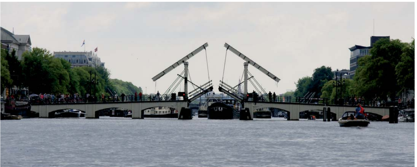
Fot. 3. Magere Brug podczas unoszenia przęsła
