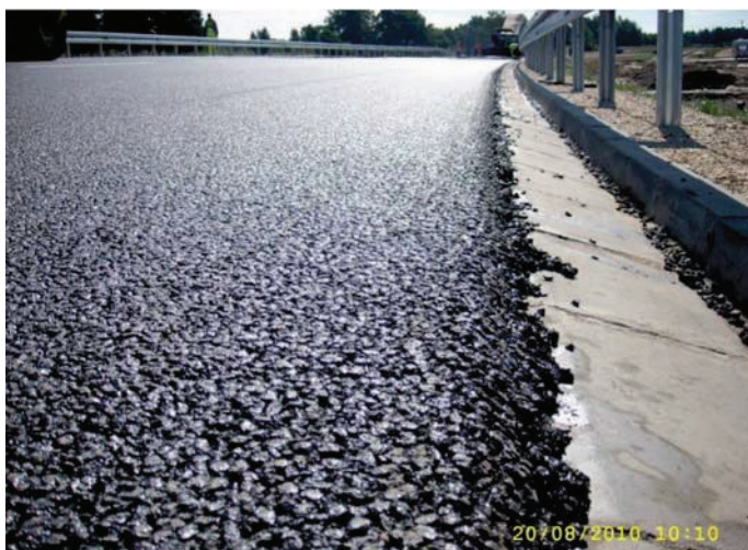
Fot. 2. Widok wykonanej nawierzchni z asfaltu porowatego – Obwodnica Mszczonowa
