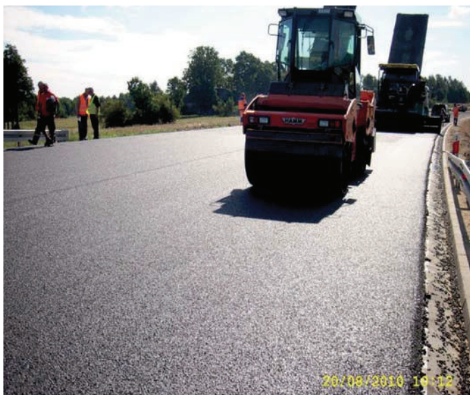
Fot. 1. Odcinek Obwodnicy Mszczonowa, asfalt porowaty – zagęszczanie warstwy
