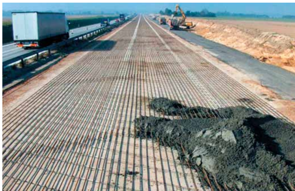
Rys. 6. Układ zbrojenia przy budowie autostrady A4
