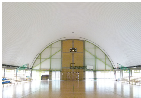
Fot. 2. Widok wewnętrzny obiektu
