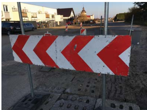
Fot. 19. Wybra- kowany oraz porysowany znak U-3d (fot. Natalia Konkel)
