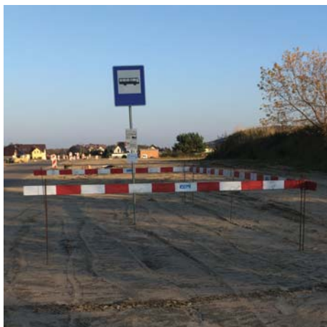
Fot. 10. Wygradzony deskami przystanek autobusowy (fot. Natalia Konkel)
