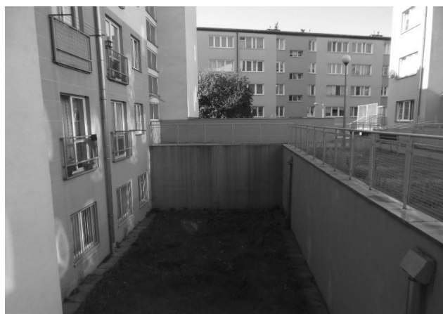
Ściany zewnętrzne części z pomieszczeniami piwnicznymi.
