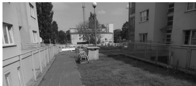
Widok na taras zielony pomiędzy budynkami, zlokalizowany bezpośrednio nad częścią z pomieszczeniami piwnicznymi.
