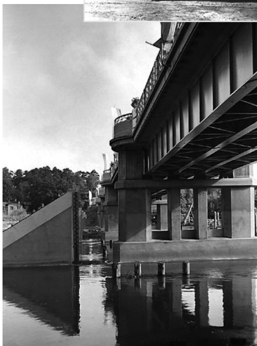
Rys. 5. Widok mostu w Spale z pokazaniem podpór i spodu konstrukcji
