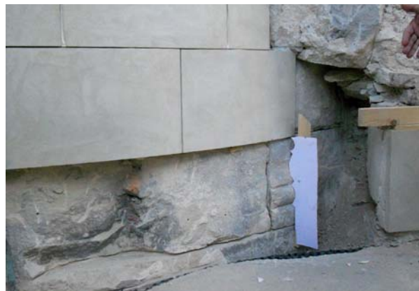
Ryc. 10. Prandocin, kościół parafialny, reszty profilowanego cokołu odsłonięte na styku ścian zachodniej kruchny i wieży (fot. St. Dziuba)
