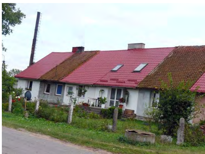
Ryc. 1. Przekształcenia zabytkowej zabudowy przy folwarcznej w Pancerzynie, wrzesień 2012 r.
