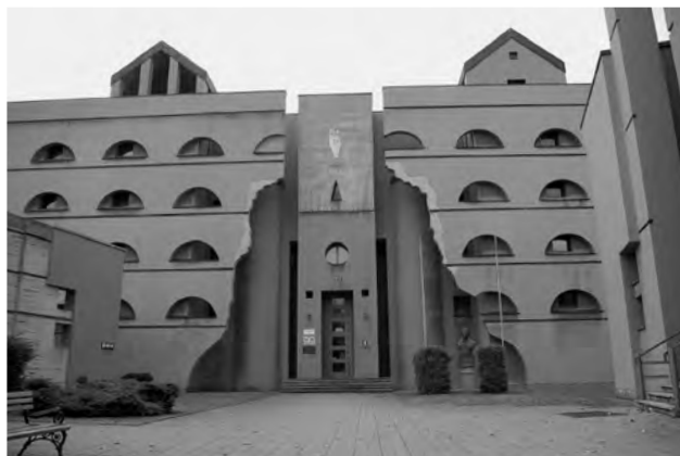
Fig. 1. The sacral center Resurrectionis XX. Zmartwychwstańców in Cracow, 1985–1993, project by Dariusz Kozłowski, Waclaw Stefański, Maria Misiągiewicz; view of a fragment from the street frontage. Ks. Pawlicki, concrete wall torn stressing the main entrance
