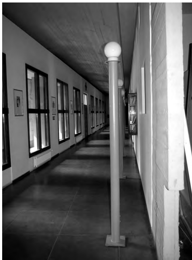
Fig. 6. The sacral center Resurrectionis XX. Zmartwychwstańców in Cracow, 1985–1993, project by Dariusz Kozłowski, Waław Stefański, Maria Misiągiewicz; fragment of the interior, finish reinforced concrete ceiling
