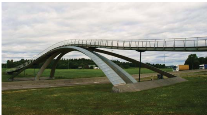
Fot. 34. Kładka drewniana w Ås nad drogą E18
