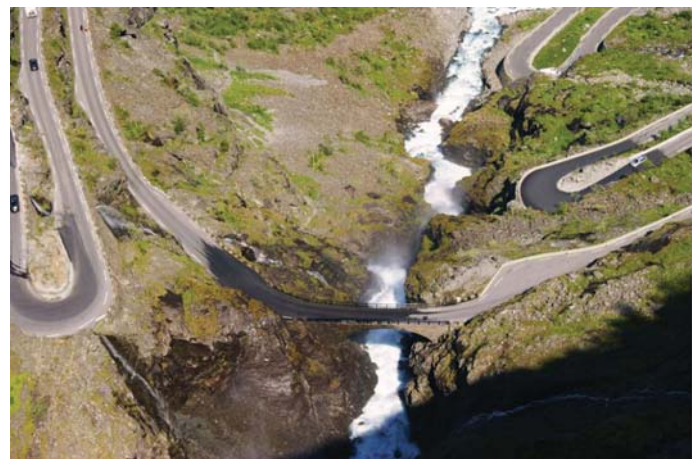
Fot. 40. Mostek kamienny nad Stigfossen na słynnej Drodze Trolli
