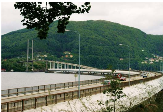
Fot. 4. Jedyńy w swoim rodzaju most pływający Nordhordland, z którego wjeżdża się bezpośrednio na most podwieszony
