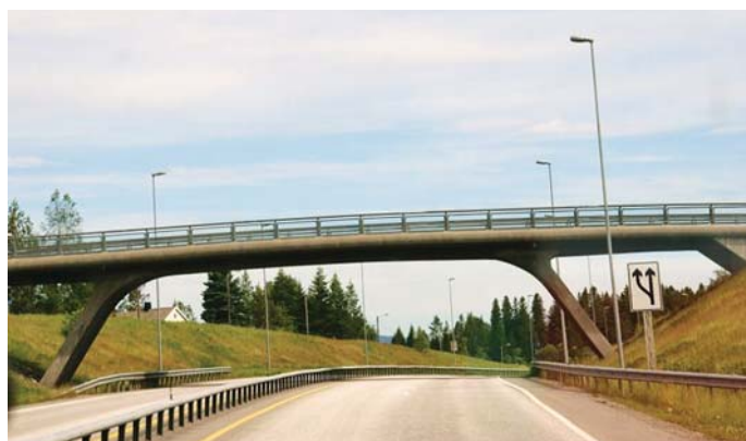
Fot. 43. Typowy wiadukt nad autostradą dojazdową do Trondheim
