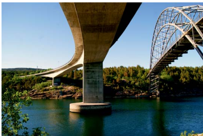
Fot. 14. Dwa mosty Omsund – nowy z betonu sprężonego z 1981 r. a obok stary kratowy z 1940 r.
