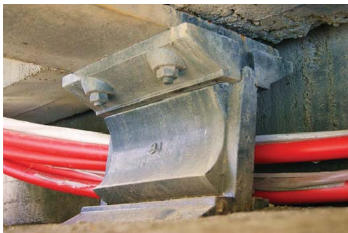
Fot. 42. Łożysko wahaczowe na przyczółku mostu zespolonego w Stryn
