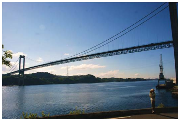
Fot. 6. Rekordowy w 1971 r. most wiszący Sotra z kratowym pomostem
