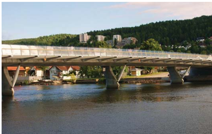
Fot. 21. Oryginalny most płytowy Øvre Sund nad Drammenselva w Drammen
