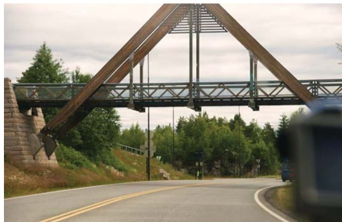
Fot. 28. Wiadukt Beston na drodze leśnej nad drogą nr 23
