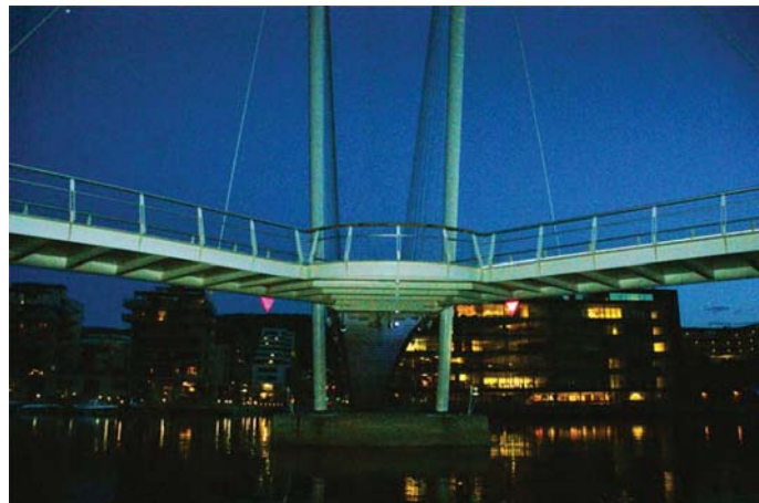
Fot. 32. Rozdwojony pomost kładki Ypsilon widoczny z drugiego brzegu
