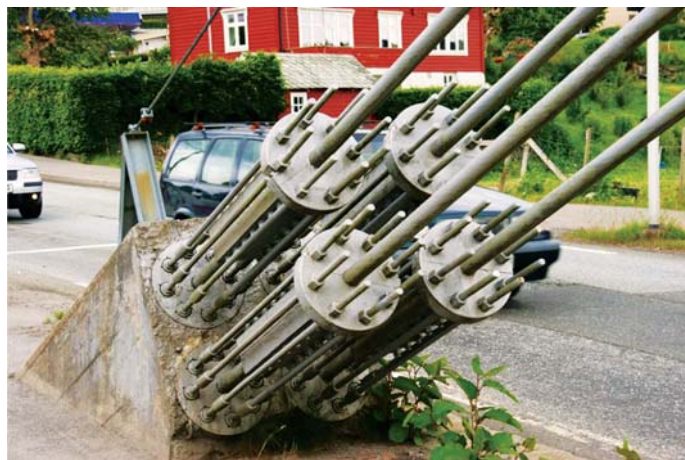
Fot. 5. Tradycyjne zakotwienie lin mostu wiszącego Alversund
