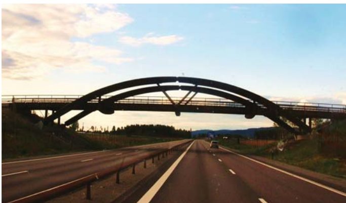
Fot. 30. Wiadukt drewniany nad drogą ekspresowa nr 7
