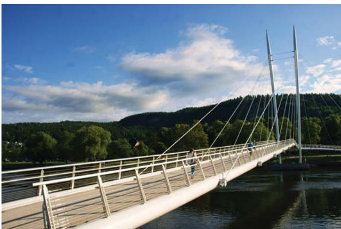
Fot. 31. Pojedynczy pomost kładki Ypsilon w Drammen
