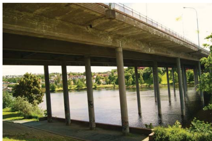
Fot. 19. Most żelbetowy Elgeseter w Trondheim
