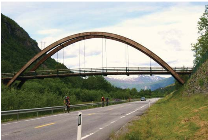
Fot. 29. Kładka drewniana nad drogą do Trollstigen
