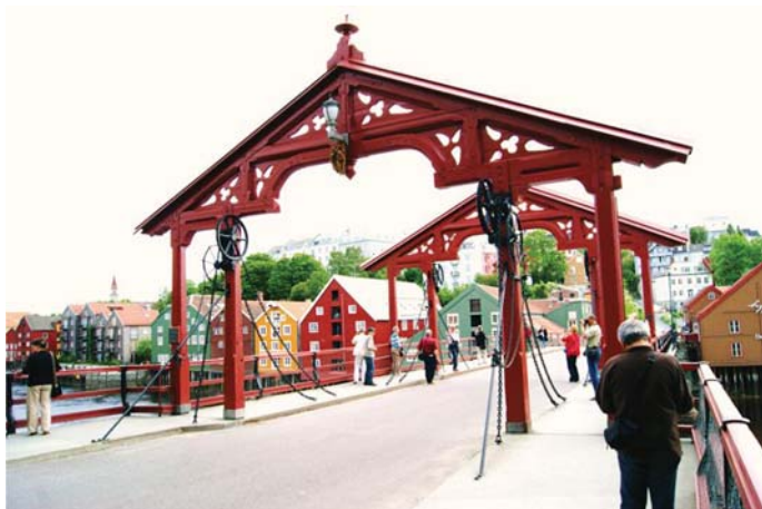
Fot. 2. Oryginalne portale mostu Starego Miasta w Trondheim
