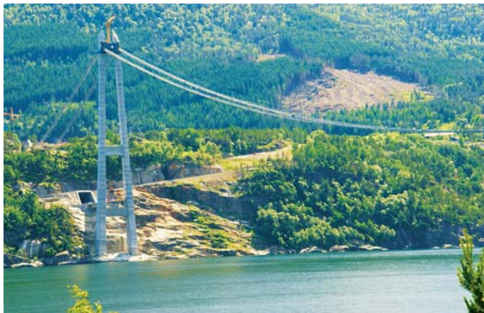
Fot. 11. Największy obecnie norweski most wiszący w czasie budowy (2012 r.)
