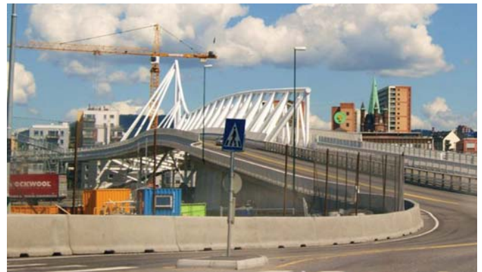
Fot. 38. Oryginalny wiadukt nad torami w Oslo z 2011 r.
