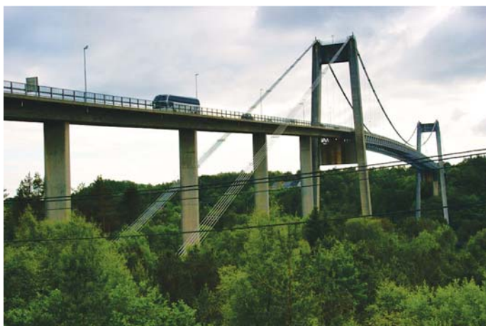
Fot. 7. Most wiszący Hagelsund z typowym norweskim olinowaniem
