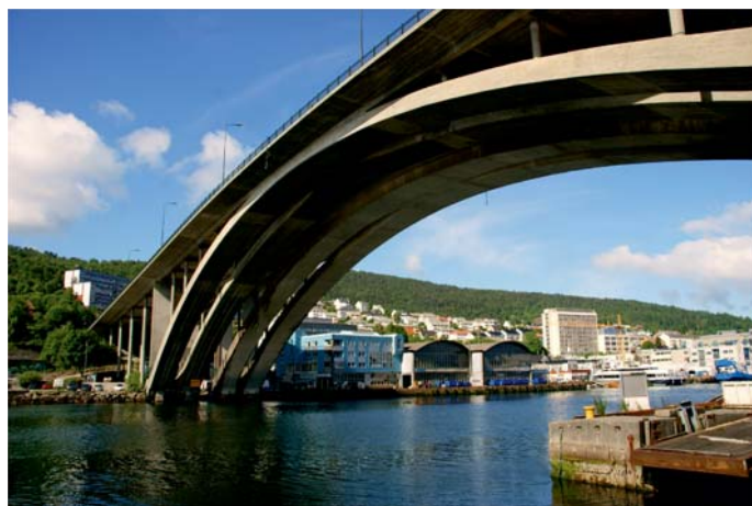
Fot. 13. Podwójny żelbetowy most łukowy Puddefjord w Bergen
