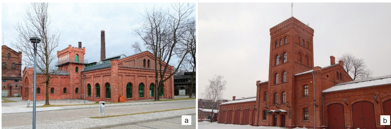
Il. 4. Zdjęcia fasad obiektów w kompleksach fabrycznych: a) elektrownia Saturn w Czeladzi, b) remiza strażacka założenia Księży Młyn w Łodzi (fot. B. Walczak, M. Grabowski)
