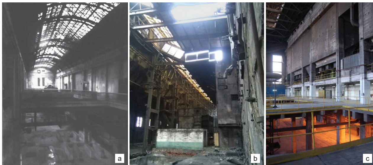
II. 6. Wnętrza hali elektrociepłowni: a, b) elektrociepłownia Szombierki w Bytomiu, c) EC2 w Łodzi (fot. B. Walczak, M. Grabowski)
