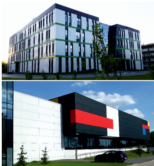
Rys. 1. Widok przykładowych elewacji wentylowanych z wykorzystaniem płyt włóknisto-cementowych na budynkach użyteczności publicznej Fig. 1. Ventilated facade with fiber-cement boards, examples of implementation and civil building
