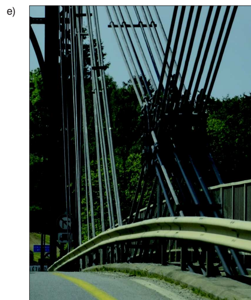
Fot. 2. Most Lézardrieux: a) widok całości, b) podpory prawobrzeżne, c) zakotwienie lin odciągowych w przeszle, d) pylony, cięgna nad pomostem, e) skrzyżowanie cięgien nad pomostem w środku mostu
