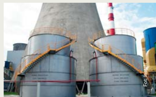
Zbiorniki magazynowe oleju rozpałkowego w Elektrowni Łagisza
