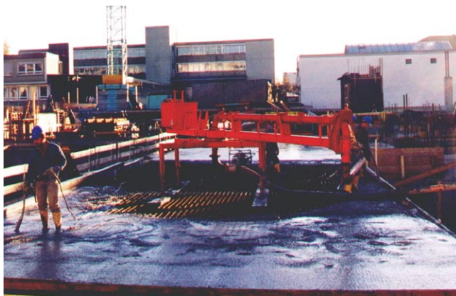
Rys. 7. Betonowanie stropu z prefabrykowanym szalunkiem wieńca (przykład w ostatnim stropie łącznika budynków G i H, wieńiec po prawej stronie zdjęcia) [5]
