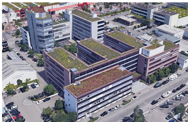
Rys. 3. Zespół obiektów biurowych – widok obecny [4]
