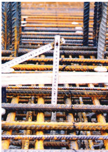
Rys. 12. Zbrojenie układane na prefabrykację stropu w rejonie słupa bez podciągu (przykład w budynku F) [5]
