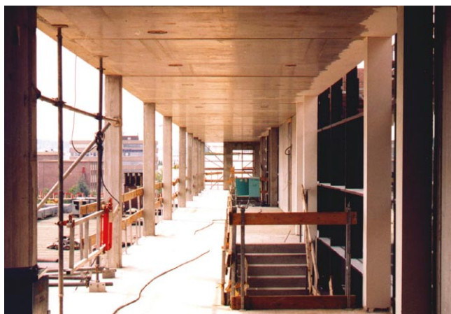
Rys. 13. Strop prefabrykowany w 6-kondygnacyjnym łączniku budynków E-H [5]
