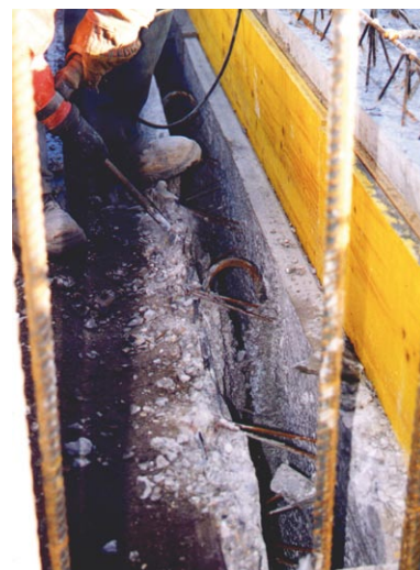
Rys. 5. Prefabrykowany element ścienny po ustawieniu (przykład na granicy budynków D i F) [5]
