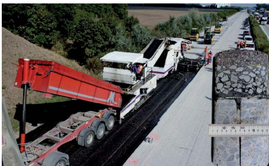
Fot. 3. Wbudowywanie warstw metodą kompaktową na sfrezowanej nawierzchni betonowej i ułożonej warstwie przeciwspekaniowej [1]
