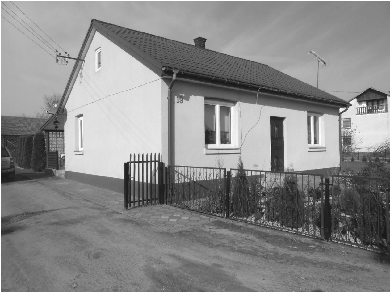
Ryc. 3. Dom o konstrukcji strychulcowej we wsi Wyszonki-Wypychy 19; fot. M. Czarkowska, 2015 Fig. 3. Wattle-and-daub house in Wyszonki-Wypychy (No. 19); photo by M. Czarkowska, 2015
