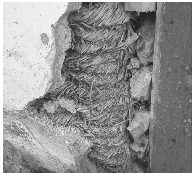
Ryc. 4, 5. Dom o konstrukcji strychulcowej we wsi Wyszonki-Wypychy 39; fot. M. Czarkowska i U. Kuczyńska, 2015
