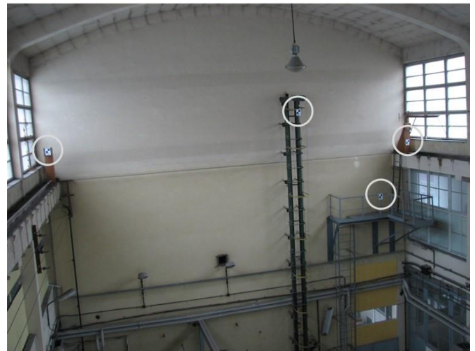
Rys. 10. Zdjęcie hali technologicznej z zaznaczonymi punktami kontrolnymi
