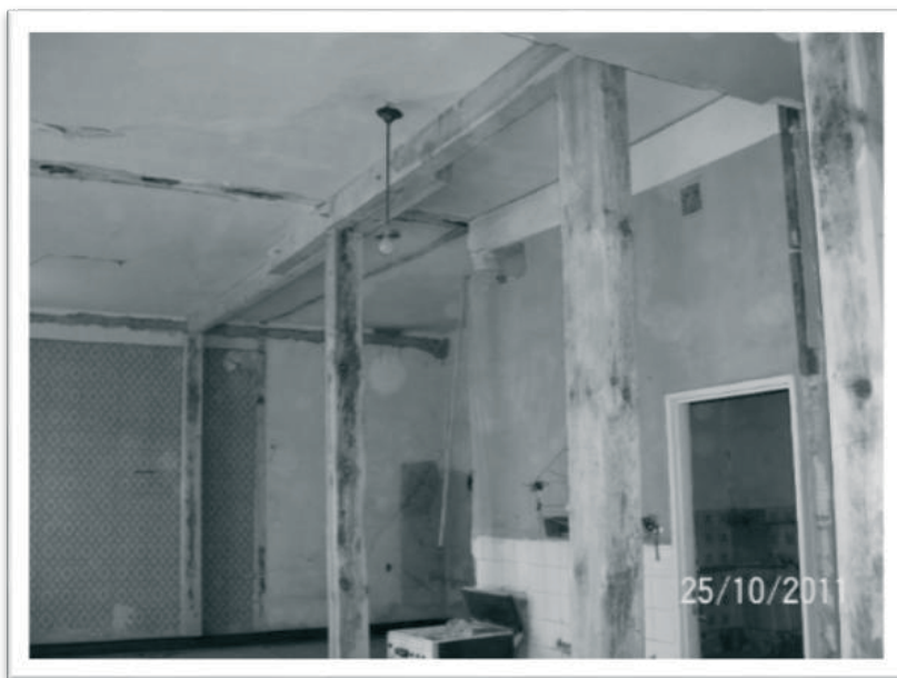
Rys. 2. Wykonanie nakazu podstemplowania stropu budynku
