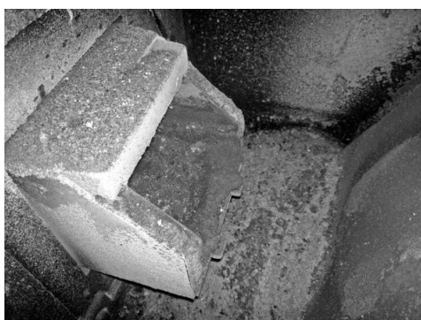
Rys. 3.3. Palenisko nasuwowe-korytkowe, widok paleniska w komorze spalania
