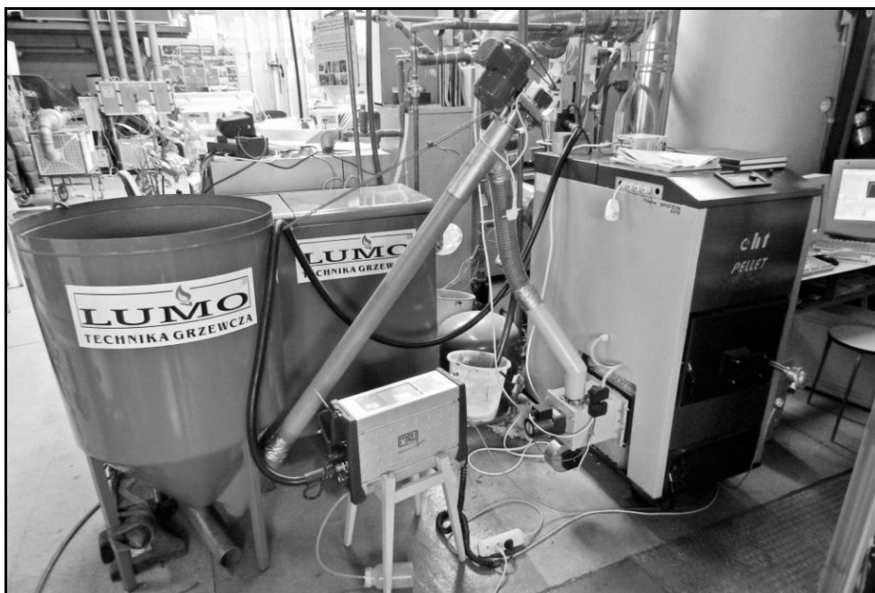
Rys. 3.2. Widok stanowiska badawczego
