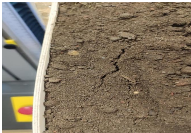
Rys. 8. Przemieszczenie fragmentów zasypu gruntowego z parciem na ściankę zasypu
