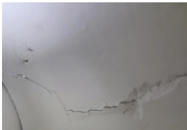
Rys. 6. Poprzeczne pęknięcia i rozwarstwienia elementów warstw konstrukcyjnych powłoki
