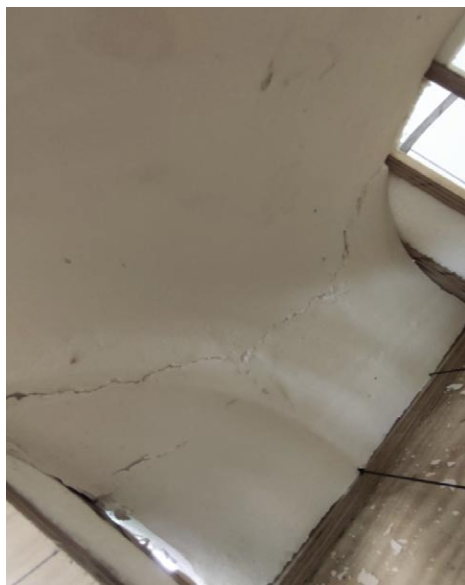
Rys. 6. Poprzeczne pęknięcia i rozwarstwienia elementów warstw konstrukcyjnych powłoki
