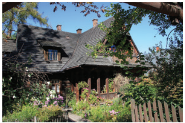
il. 2. Budynek mieszkalny w stylu „Witkiewiczowskim” w Zakopanem, ul. Nowotarskiej / Residential building in "Witkiewicz's style" in Nowotarska St., Zakopane
