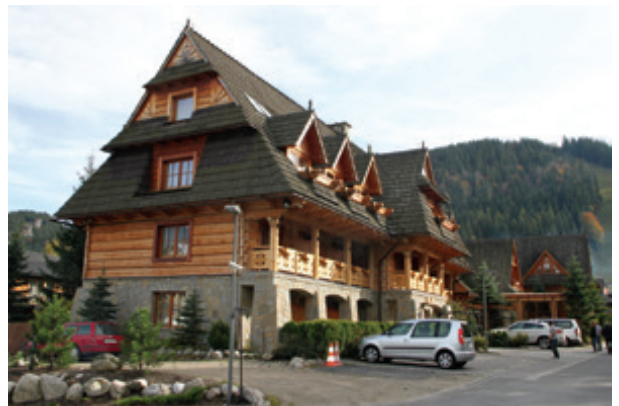
il. 4. Współczesny budynek pensjonatowy nawiązujący do stylu „Witkiewiczowskiego” w Zakopanem / Contemporary pension referring to "Witkiewicz's style" in Zakopane
