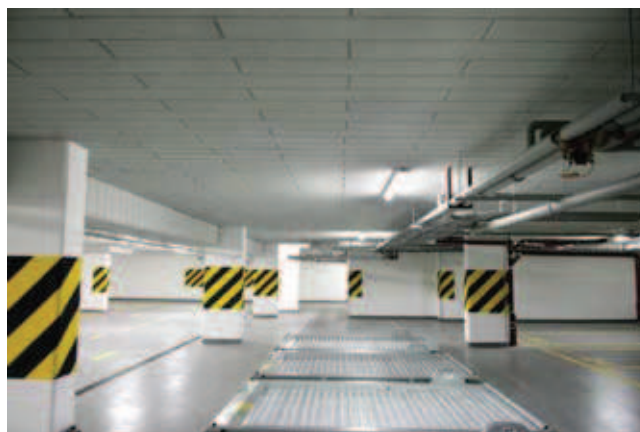
Rys. 3. Izolacja z wełny mineralnej w garażu podziemnym (źródło: materiały firmy PAROC, www.paroc.pl)
