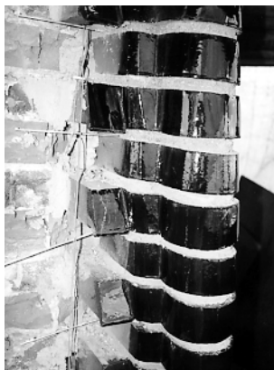
Rys. 14. Murowanie elementów narożnych
