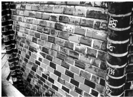
Rys. 9. Oczyszczona powierzchnia najmniej uszkodzonej północno-wschodniej pości helmu
