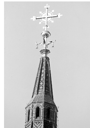
Rys. 19. Szczegół latarni oraz nowy krzyż
