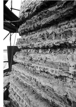
Rys. 13. Pierwszy etap renowacji – usunięcie zniszczonej warstwy licowej
