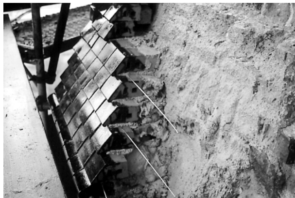
Rys. 15. Murowanie kolejnych warstw licówki, zbrojonej co drugą spoiną wsporną
