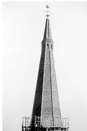
Rys. 18. Hełm wieży po renowacji
