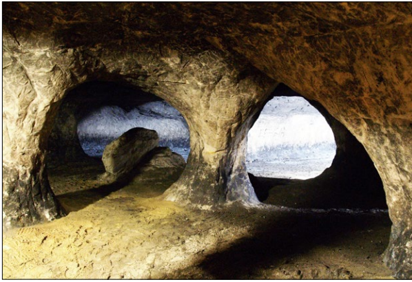
Ryc. 1. Kryterium autentyczności (forma przestrzenna) – pierwotna forma przestrzenna typu komorowego w kopalni piasków szklarskich w Nagórzycach (Groty Nagórzycckie); fot. T. Wieja.
