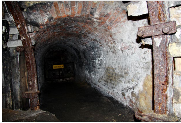
Ryc. 2. Kryterium autentyczności (systemy zabezpieczeń, geometria i materiał obudowy) – pierwotna obudowa ceglana w kopalni Nowa Ruda.
