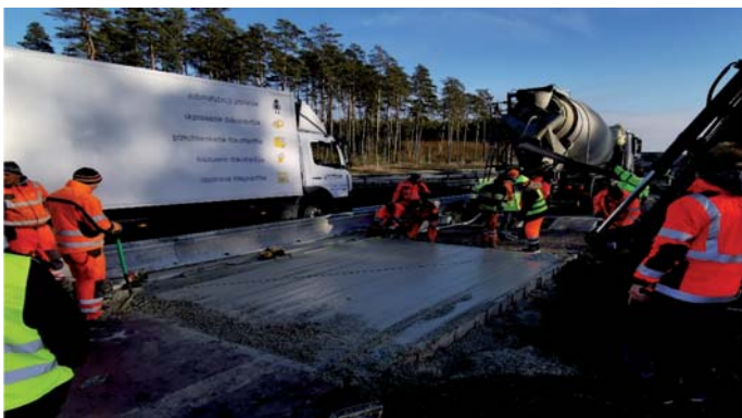
Fot. 31. Naprawa kompleksowa – wymiana górnej warstwy jezdnej. Mieszanka betonu szybkostrawnego. Autostrada A4 [8]
