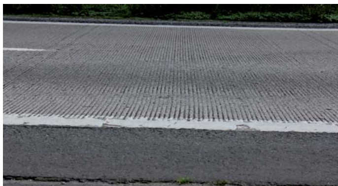
Fot. 1. Nawierzchnia betonowa w Belgii – okolice miejscowości Namur – 47 lat użytkowania [4]
