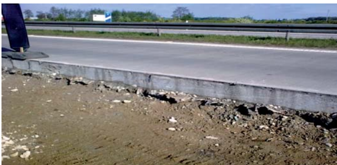
Fot. 29. Naprawa kompleksowa – wymiana całej grubości konstrukcji nawierzchni. Autostrada A4 [8]
