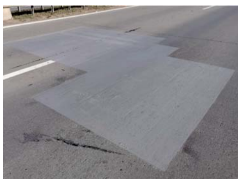
Fot. 24. Efekt naprawy przy pomocy preparatów systemowych na bazie żywic epoksydowych. Autostrada A4 [8]
