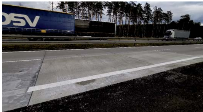
Fot. 32. Końcowy efekt naprawy kompleksowej za pomocą wymiany górnej warstwy jezdnej. Mieszanka betonu szybkostrawnego. Autostrada A4 [8]
