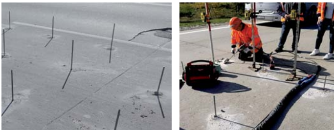
Fot. 27–28. Naprawa za pomocą iniekcji substancji na bazie geopolimerów. Autostrada A4 [4]
