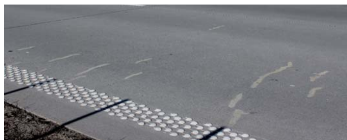
Fot. 24. Efekt naprawy przy pomocy preparatów systemowych na bazie żywic epoksydowych. Autostrada A4 [8]
