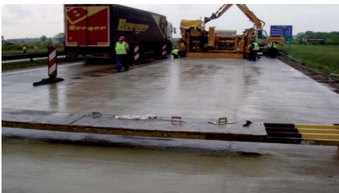
Fot. 30. Naprawa kompleksowa – wymiana całej grubości konstrukcji nawierzchni. Klasyczna mieszanka betonu nawierzchniowego. Autostrada A4 [8]
