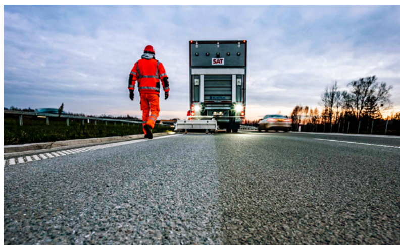
Śrutownica na drodze ekspresowej S17 Warszawa – Kołbiel
