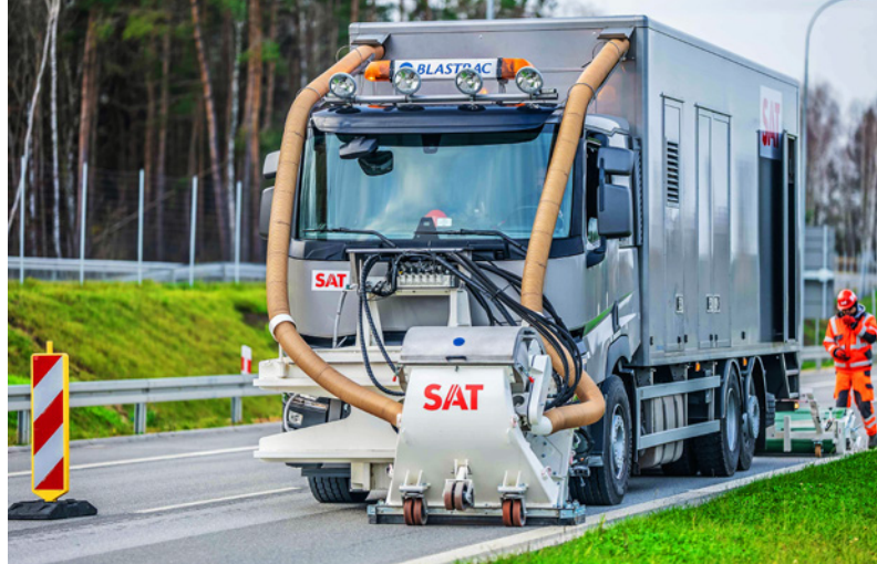
Śrutownica na drodze ekspresowej S17 Warszawa – Kołbiel
