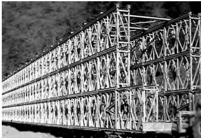
Rys. 1. Mosty składane Bailey w układzie DT
