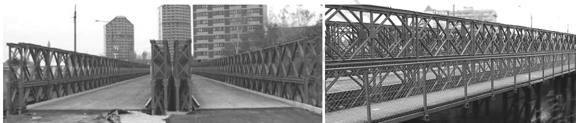
Rys. 5. Tymczasowy most MS 22-80 na rzece Odra we Wrocławiu 3 w układzie 2 x 2/2
