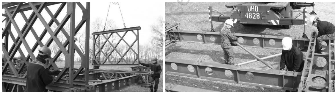
Rys. 11. Budowa mostu DMS-65 przez pchor. WSOWL w 2pinż. w Inowrocławiu (16-20.04.2012 r.)
