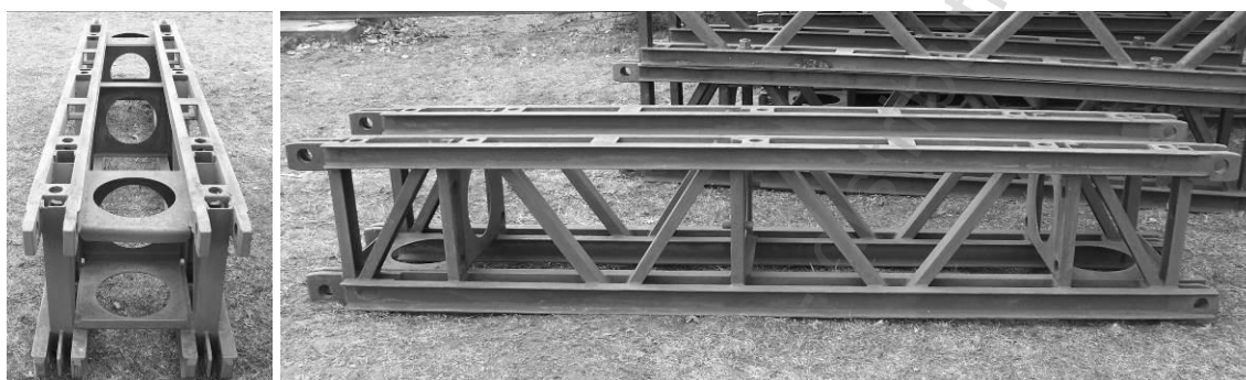
Rys. 12. Kratownica płaska (płaski element kratowy) mostu DMS-65
