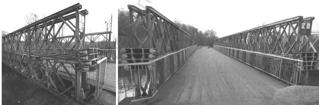
Rys. 8. Konstrukcja mostu MS 22-80 ze sprężonym przęsłem
