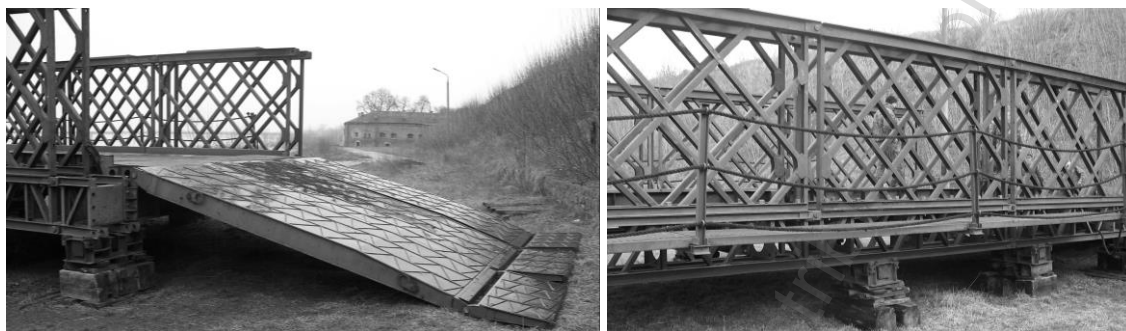
Rys. 3. Pomost wjazdowo-zjazdowy i element chodnika umieszczonego na wspornikach mostu DMS-65 Źródło: Material własny – Ibdm Dęblin (03.2014 r.)
