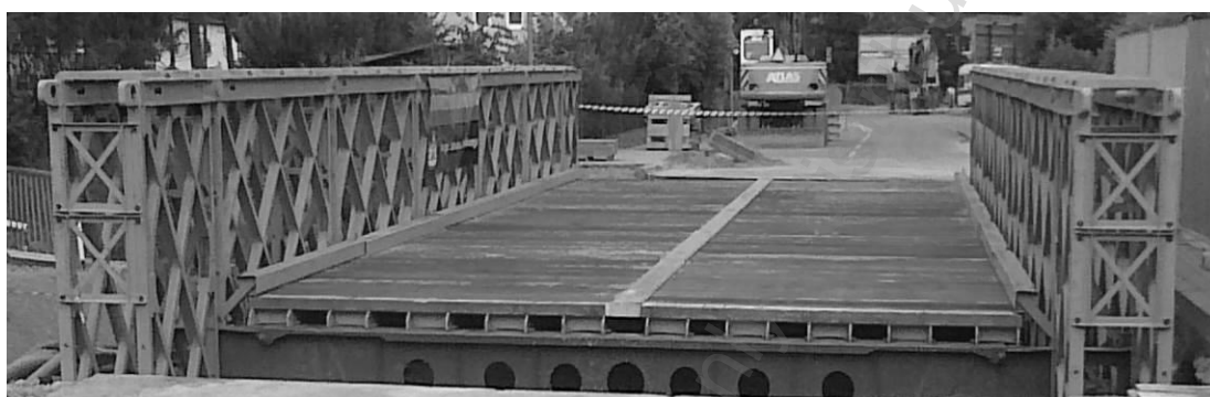
Rys. 9. Most MS-54 w układzie 2/1 w Jeleniej Górze zbudowany przez 2pinż z Inowrocławia (07.2012 r.)
