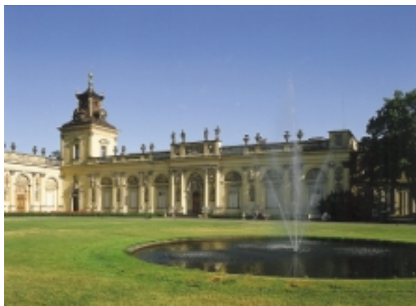
Skrzydło południowe pałacu przed konserwacją. Fot. M. Wideryński
