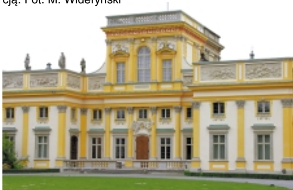
Korpus Główny – elewacja zachodnia po konserwacji. Fot. W. Markiewicz
