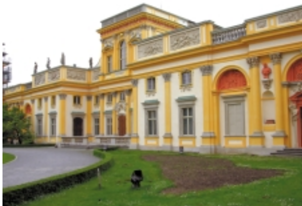
Korpus Główny – elewacja zachodnia pałacu po konserwacji. Fot. W. Markiewicz
