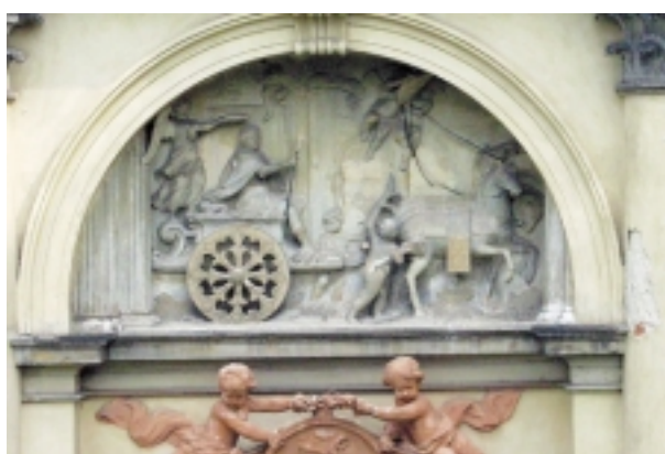
Płaskorzeźba w archiwolcie na elewacji frontowej galerii południowej – Jan III Sobieski na rydwanie triumfalnym przed konserwacją. Fot. T. Nakonieczny
