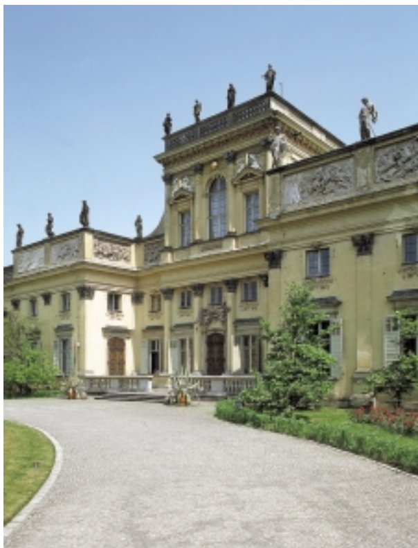
Korpus Główny – elewacja zachodnia pałacu przed konserwacją. Fot. M. Wideryński
