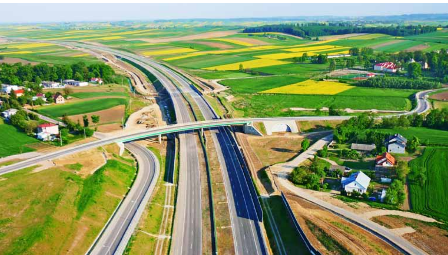
Wiadukt drogowy WD-231
