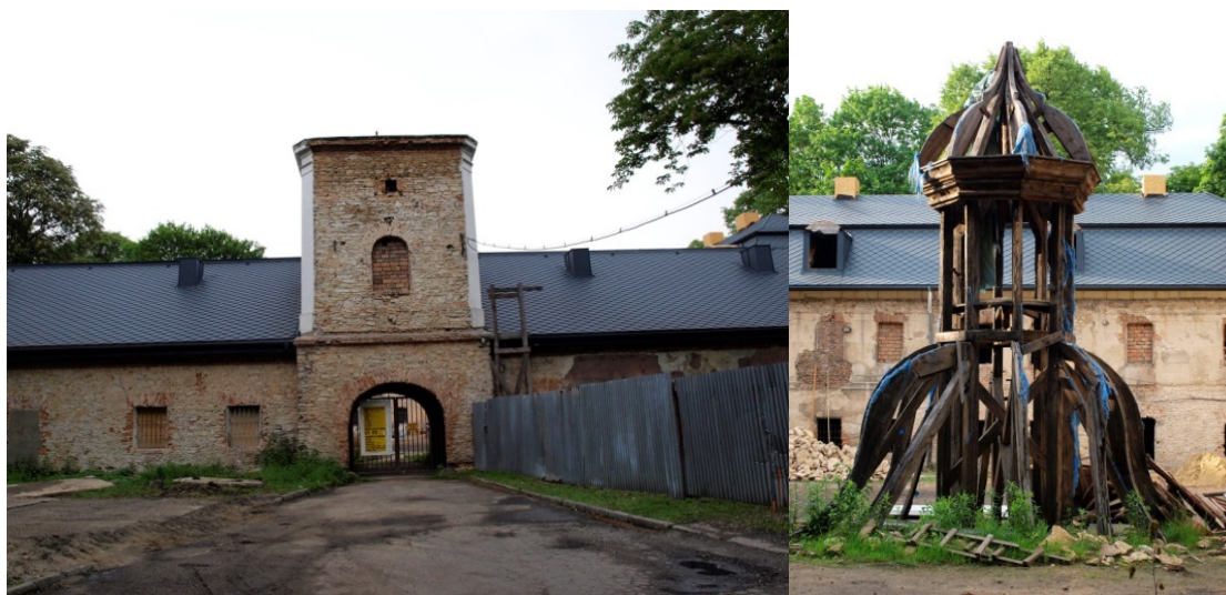
Rys. 1. Wieża bramna oraz jej zdemontowana kopuła, maj 2016 (fot. źródło własne).
