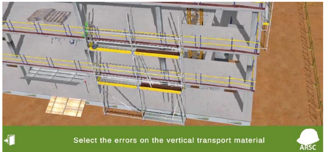
Rys. 18. Przykład wykorzystania AR na budowie – fragment szkolenia z bezpiecznego wykonywania rusztowań (opracowanie własne)
